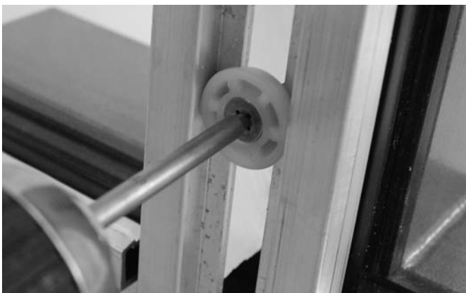
Abb. 29 SR1 Schraube M5 mit Zentrierscheibe mittels Akku-Bohrschrauber anziehen
