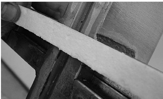
Abb. 10 Im Kreuzpunkt-Bereich werden die Keramikfaserbänder durchgehend aufgeklebt. Fig. 10 Les bandes de fibre de céramique de la zone de la traverse sont collées d'un bout à l'autre dans la zone du point de croisée.
