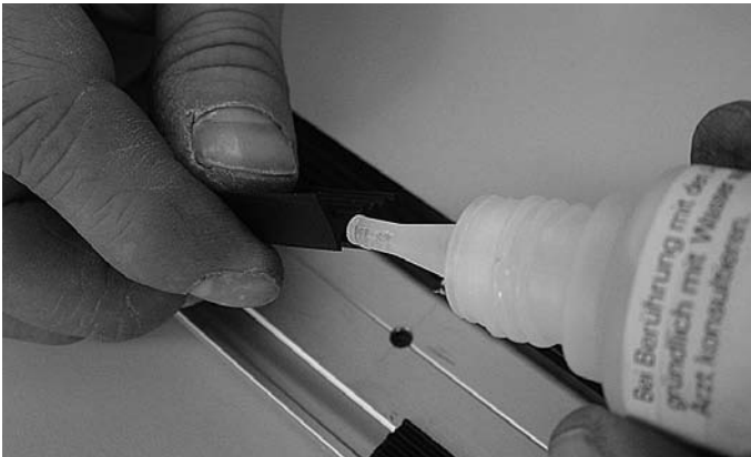
Abb. 81 Eingedrückte Horizontaldichtung mit Dichtungs-Formstück mittels Schnellkleber verkleben Fig. 81 Coller le joint horizontal enfoncé avec le joint de bout avec une colle express
