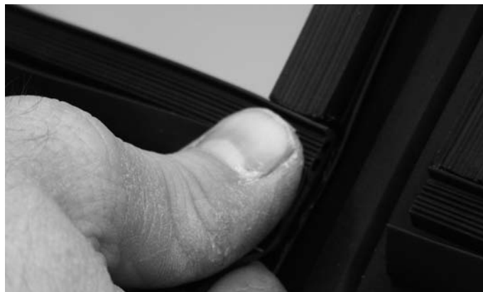
Abb. 59 Horizontaldichtung oben in Kreuzpunkt positionieren Fig. 59 Positionner le joint horizontal sur le point de croisée
