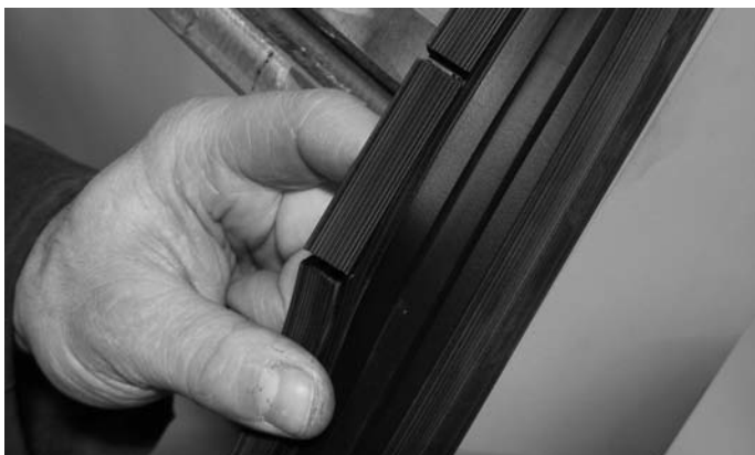
Abb. 41 Eingeschnittene Vertikaldichtung Fig. 41 Joint vertical entaillé
