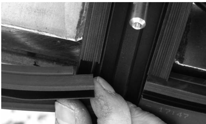
Abb. 50 Platzieren der Horizontaldichtung im Kreuzpunkt Fig. 50 Positionner le joint horizontal au point de croisée
