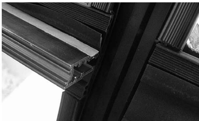
Abb. 69 Das Riegel-Falzprofil muss seitlich bündig mit der Horizontaldichtung aufgeschlagen werden Fig. 69 Le profilé de feuillure traverse doit être à fleur latéralement avec le joint horizontal
