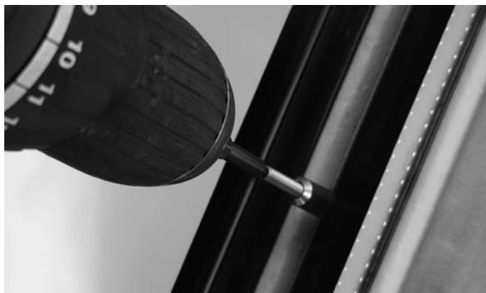
Abb. 23 Eindrehen der Gewindestifte in Brandschutzanker (Sparren- und Riegelbereich) Fig. 23 Ancrage de la vis sans tête dans le boulon d'ancrage anti-incendie verticale (zone du chevron et montant)
