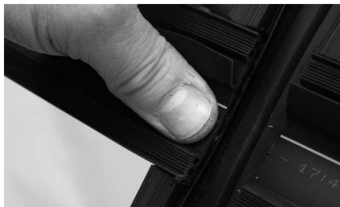
Abb. 61 Horizontaldichtung auf Butyl-Dichtstück andrücken Fig. 61 Enfoncer le joint horizontal sur la pièce en butyle
