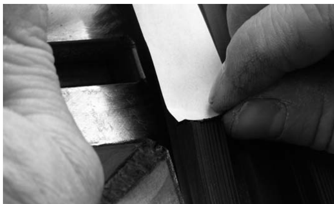
Abb. 55 Butyl-Dichtstück unten in der Ausklinkung ausrichten
