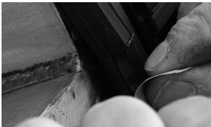
Abb. 58 Schutzfolie vom Butyl-Dichtstück abziehen Fig. 58 Retirer la feuille de protection de la feuille adhésive
