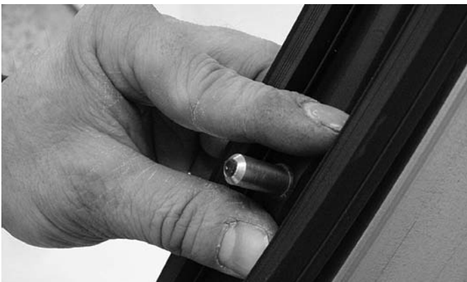
Abb. 32 Dichtung andrücken
