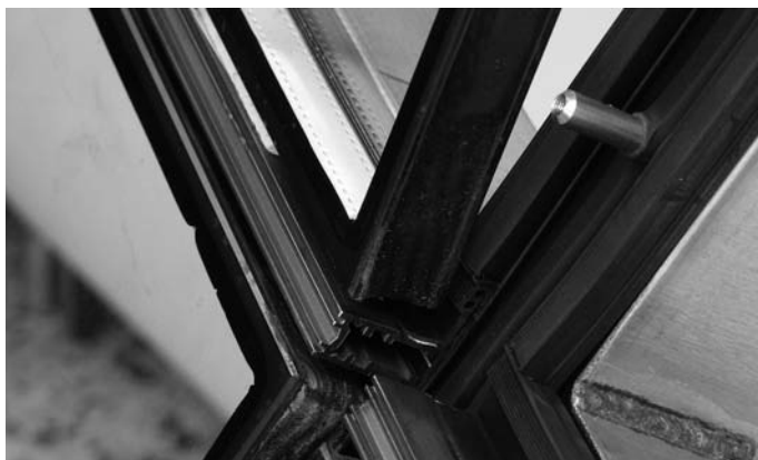
Abb. 91 Füllelement auf Glasauflager absetzen und oben anlegen Fig. 91 Poser l'élément de remplissage sur le support de verre et le placer dessus
