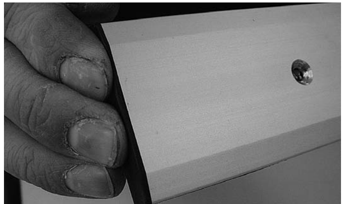
Abb. 79 Dichtungs-Formstück an Anschraubprofil andrücken Fig. 79 Presser le joint de bout sur le profilé à visser
