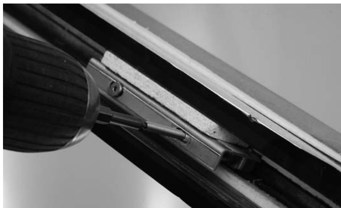
Abb. 24 Eindrehen Gewindestifte bei Glasauflagen Fig. 24 Ancrage de la vis sans tête pour les supports de verre
