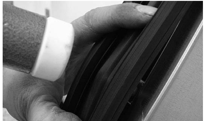
Abb. 32 Aufschlagen der Dichtung mittels Nylonhammer
