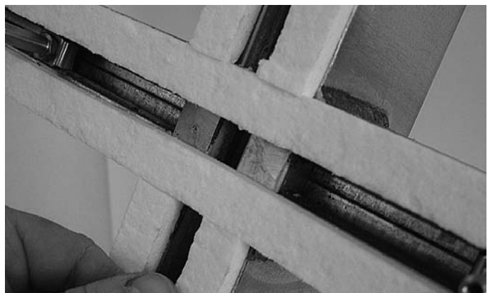
Abb. 11 Die vertikalen Keramikfaserbänder werden im Kreuzpunkt-Bereich zwischengesetzt. Fig. 11 Les bandes de fibre de céramique verticales sont intercalées dans la zone du point de croisée.
