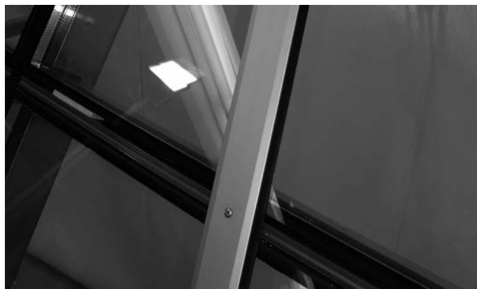
Abb. 92 Füllelement z.B. mit Anschraubprofil sichern Fig. 92 Assurer l'élément de remplissage p.ex. avec la pièce du profilé à visser
