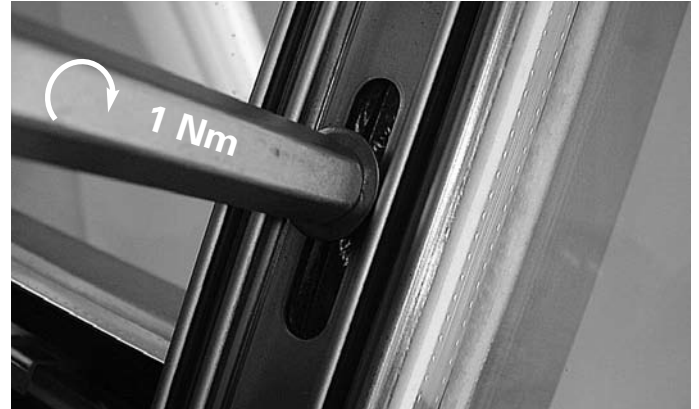
Abb. 27 Anpressprofil mittels Zentrier Mutter und Spezialschlüssel 499.254 anziehen, Drehmoment 1 Nm. Fig. 27 Visser le profilé de fixation und Spezialschlüssel 499.254 anziehen, couple de serrage 1 Nm.
