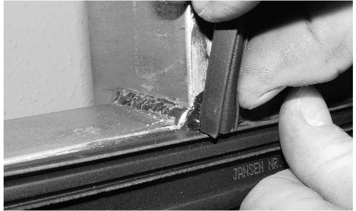
Abb. 11 Dichtung anlegen und satt andrücken
