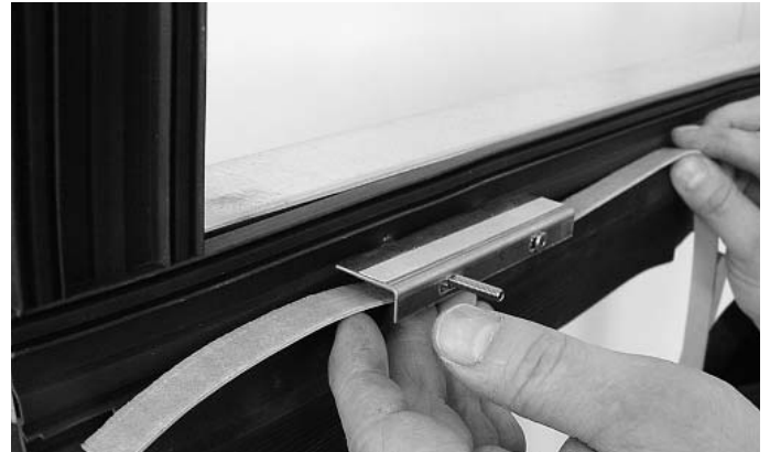
Abb. 48 Brandschutzlaminat im Riegel-Bereich unten an Glasaufleger resp. Brandschutzanker kleben.
