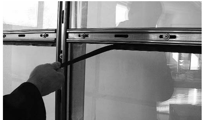
Abb. 40 Dichtungslappens abreißen Fig. 40 Arracher la languette
