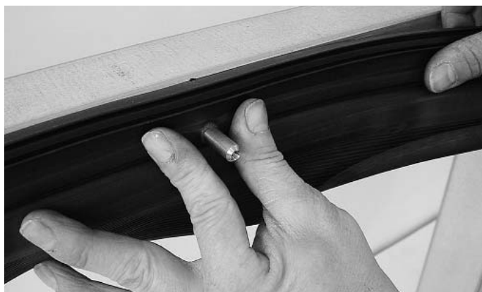
Abb. 9 Dichtung andrücken Fig. 9 Presser le joint
