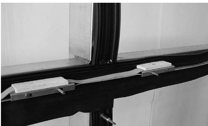
Abb. 51 Brandschutzlaminat im Kreuzpunkt-Bereich horizontal durchlaufend
