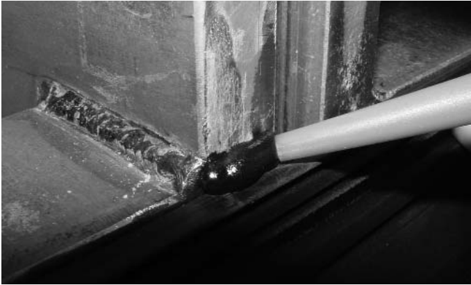
Abb. 10 Vertikaldichtung unten mit Dichtmasse* verkleben. Kleberraupe im Pfostenbereich auftragen.
