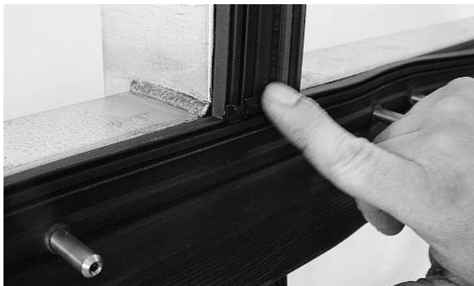
Abb. 16 Ausstreichen der Dichtmasse* im Bereich Vertikal-/ Horizontaldichtung
