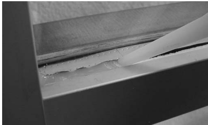
Abb. 35 Auftrag der Dichtungsmasse Fig. 35 Etalement de la pâte à étancher
