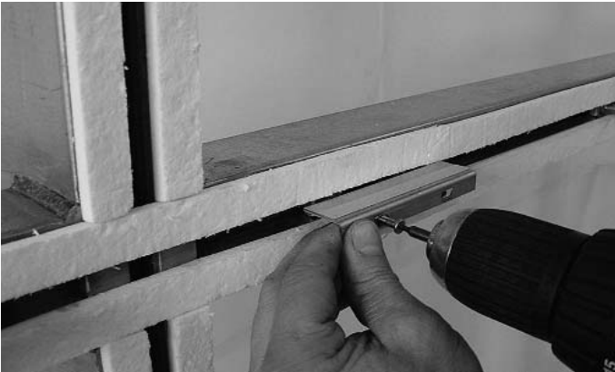
Abb. 12 Einsetzen und Befestigen der Glasauflagen mittels M4-Schraube Fig. 12 Pose et fixation des supports de verre au moyen de la vis M4
