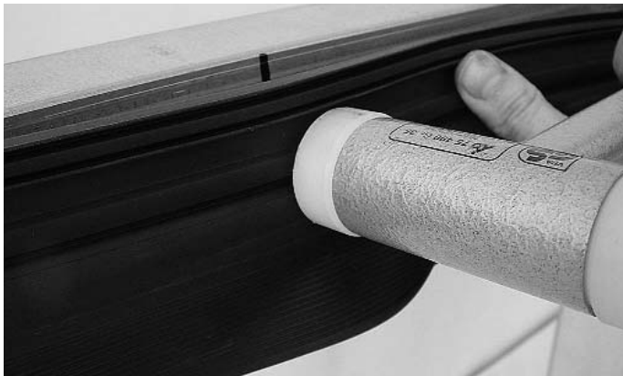
Abb. 7 Aufschlagen der Dichtung mittels Nylonhammer Fig. 7 Pose du joint au moyen du marteau en nylon
