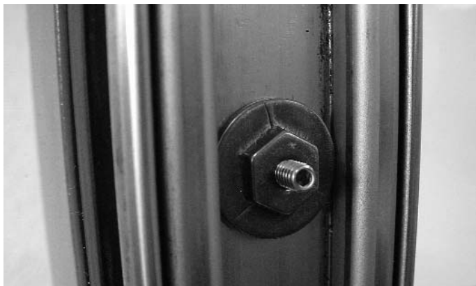
Abb. 33 M4-Spezial-Zentriermutter für die Montage der Anpressprofile. Überstand Gewindestift min. 2 mm. Fig. 33 Ecrou de centrage spécial M4 pour le montage des profilés de fixation. Dépassement de la tête sans vis min. 2 mm.
