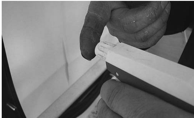
Abb. 15 Zeigfinger mit Seifenwasser benetzen um die aufgetragene Dichtmasse* verstreichen zu können.
