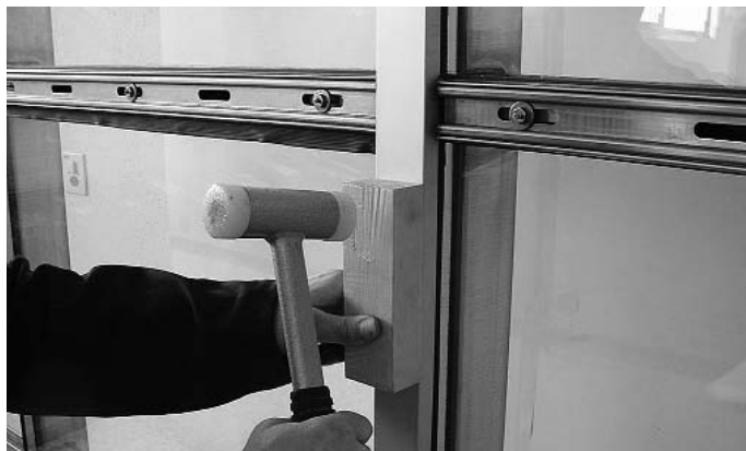
Abb. 41 Aufschlagen der vertikalen Abdeckprofile Fig. 41 Frappe des profilés de recouvrement verticaux
