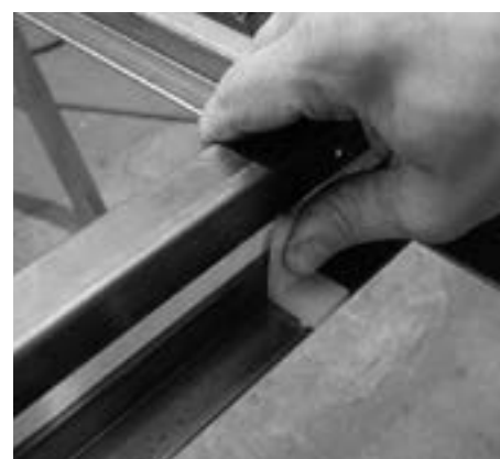
Belüftungswinkel aufstecken Monter l'équerre de ventilation Plugging-in the angle for glazing rebate ventilation
