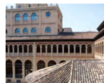
15 Informationsgebäude der Universität Zaragoza, Zaragoza/ES
