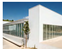
5 Hauptschule Lima de Freitas, Setubal/PT
