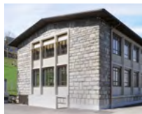
10 Pumpwerk Schönau, WVRB AG, Bern/CH
