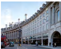
9 Gebäudesanierung, Regent Street, London/GB
