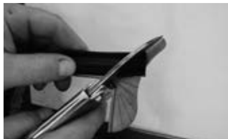
Zuschnitt Aussendichtung Coupe joint extérieur Cutting outer weather strip to size
