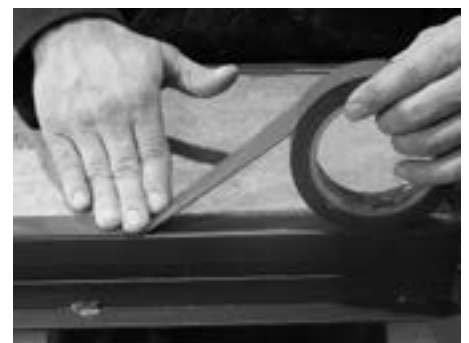
Klebeband auf Türflügel-Rahmen aufbringen
