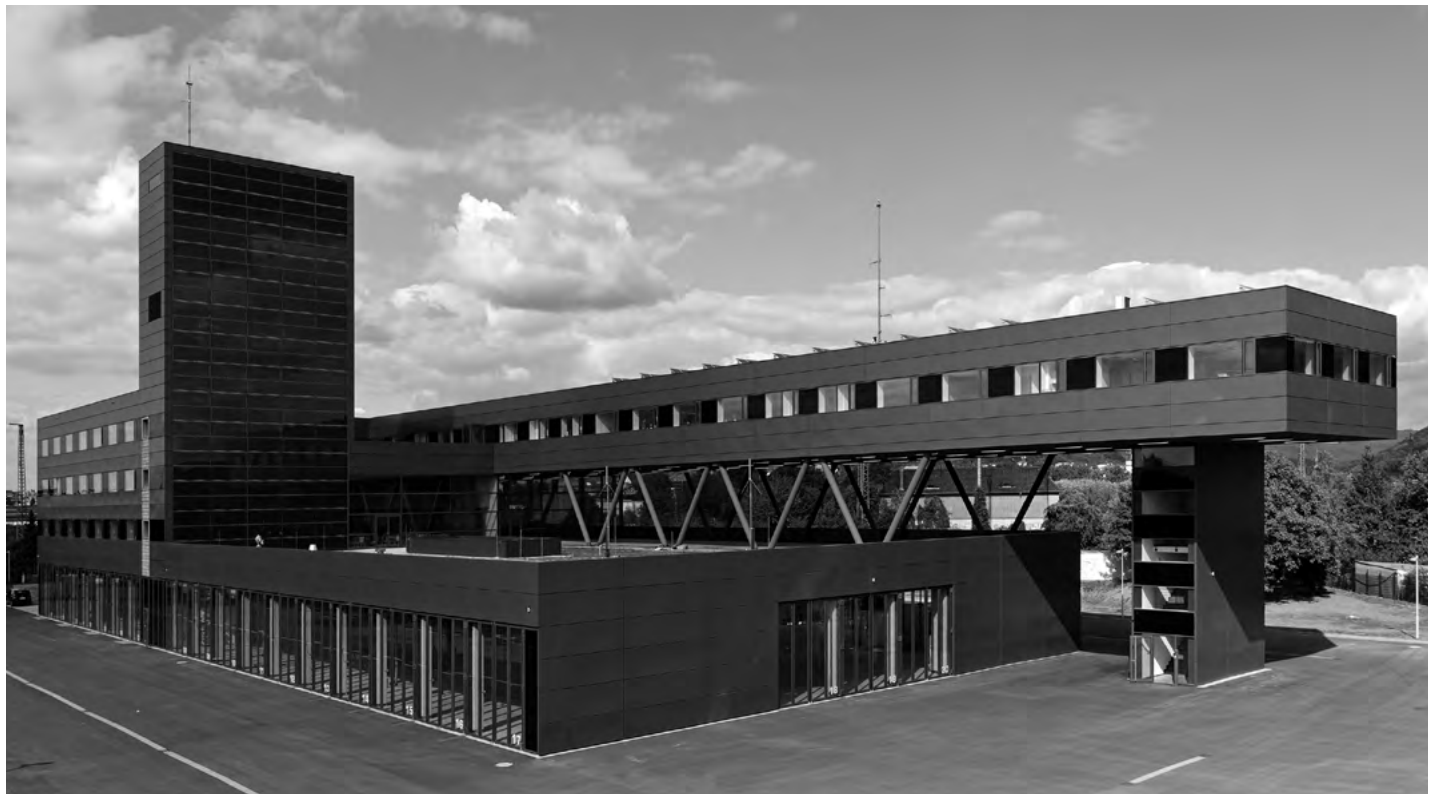
Feuerwehrwache Heidelberg, Heidelberg/D
