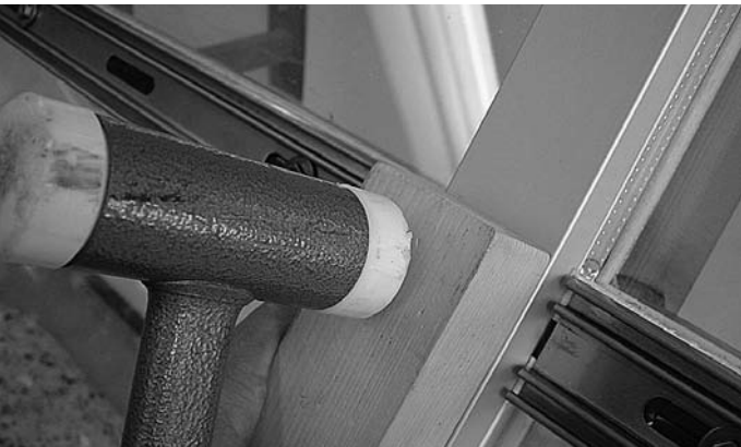
Abb. 30 Aufschlagen der Abdeckprofile mit Schutzholz und Nylonhammer Fig. 30 Frappe des profilés de recouvrement avec bois de protection et marteau en nylon
