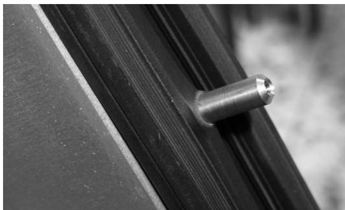
Abb. 33 Leichte Wölbung im Bereich der Brandschutzanker
