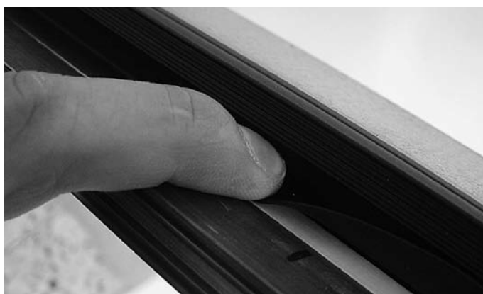
Abb. 71 Dichtungslappen fest und gleichmässig andrücken Fig. 71 Presser fortement et régulièrement les languettes d'étanchéité
