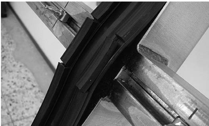
Abb. 36 Eingeschnittene Vertikaldichtung Fig. 36 Joint vertical entaillé
