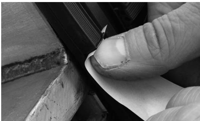
Abb. 54 Butyl-Dichtstück oben in der Ausklinkung ausrichten
