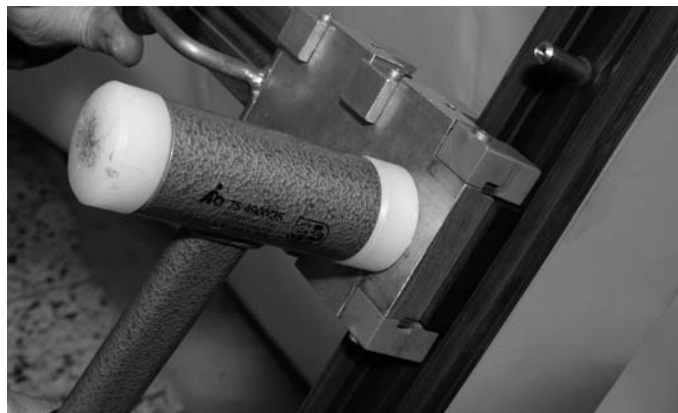
Abb. 40 Kräftiger Hammerschlag auf die Ausklinklehre Fig. 40 Coup de marteau puissant sur gabarit d'entaille
