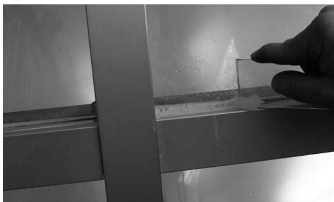
Abb. 34 Silikon mit einem Kunststoffspachtel abziehen Fig. 34 Retirer la silicone avec une spatule en plastique
