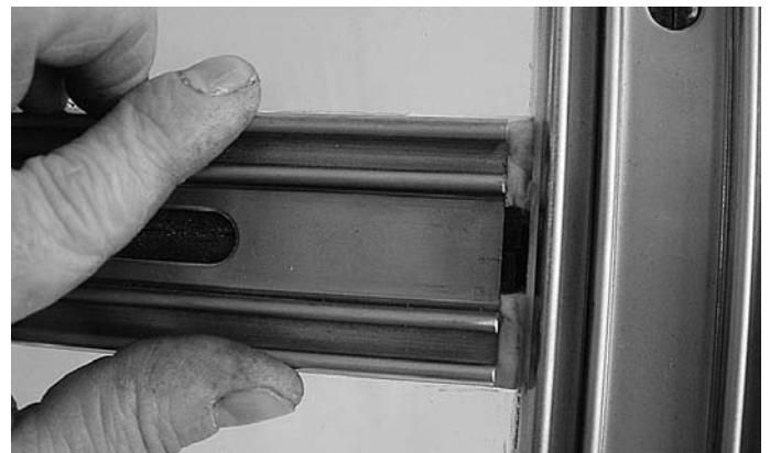
Abb. 29 Horizontales Anpressprofil anlegen. Seitliches Spiel gleichmässig verteilen. Fig. 29 Poser le profilé de fixation horizontal. Veiller à ce que le jeu soit réparti régulièrement des deux côtés.
