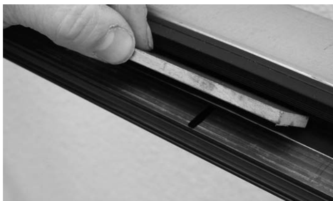
Abb. 89 Tragklotz über Traganker mit Klebeband aufkleben Fig. 89 Coller la cale pour support sur le boulon-support avec de la bande adhésive
