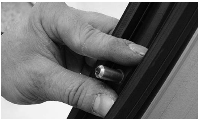
Abb. 32 Dichtung andrücken
