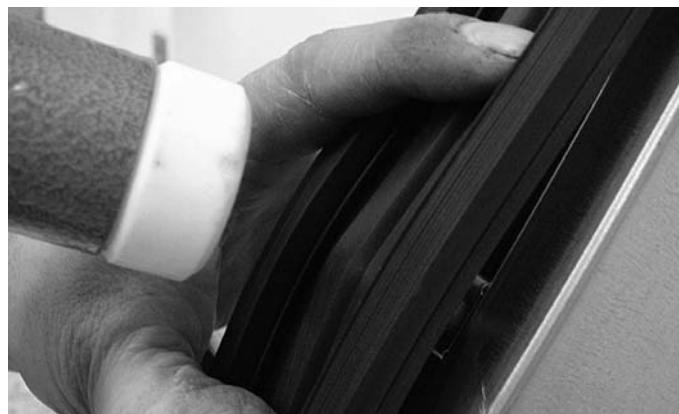
Abb. 32 Aufschlagen der Dichtung mittels Nylonhammer
