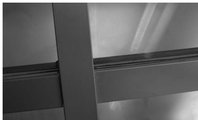
Abb. 35 Versiegelte Fuge Fig. 35 Joint jointoyé
