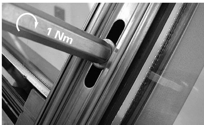
Abb. 99 Zentriermutter mit Akku-Schrauber montieren (Drehmoment 1 Nm) Fig. 99 Monter l'écrou de centrage avec la visseuse à accumulateur (couple de serrage 1 Nm)
