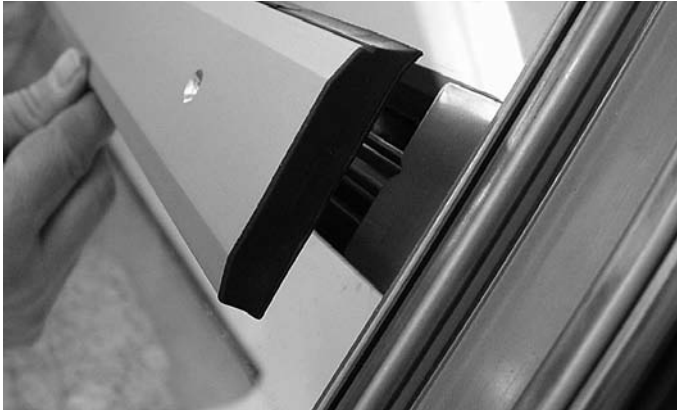
Abb. 104 Riegel-Anschraubprofil seitlich ausrichten Fig. 104 Orienter latéralement le profilé à visser (traverse)
