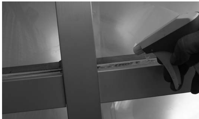
Abb. 33 Silikon vor dem Abstreifen mit Seifenwasser besprühen Fig. 33 Vaporiser la silicone à l'eau savonneuse avant de racler
