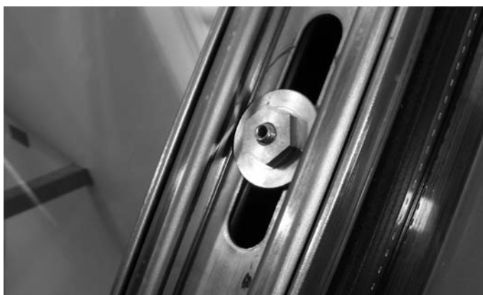
Abb. 101 Montierte Zentriermutter Fig. 101 Ecrou de centrage monté
