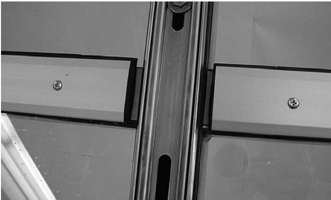
Abb. 106 Montierte Anschraubprofile im Kreuzpunkt Fig. 106 Profilés à visser montés du point de croisée
