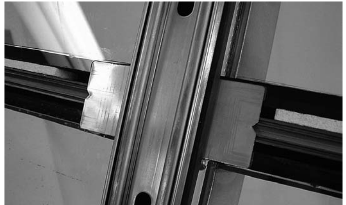
Abb. 103 Kreuzpunkt-Dichtungsplatte mit Anpressprofil Fig. 103 Plaque d'étanchéité du point de croisée et profilé de fixation
