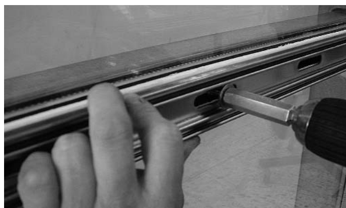
Abb. 22 Horizontales Anpressprofil festschrauben. Anziehen mit Spezialschlüssel 499.254, Drehmoment 1 Nm. Fig. 22 Visser le profilé de fixation horizontal à fond. Serrage avec clé spéciale 499.254, couple de serrage 1 Nm.
