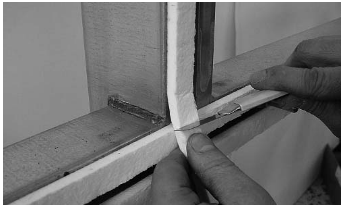
Abb. 5 Zuschnitt der vertikalen Keramikfaserbänder im Kreuzpunkt-Bereich Fig. 5 Coupe des bandes de fibre de céramique verticales dans la zone du point de croisée
