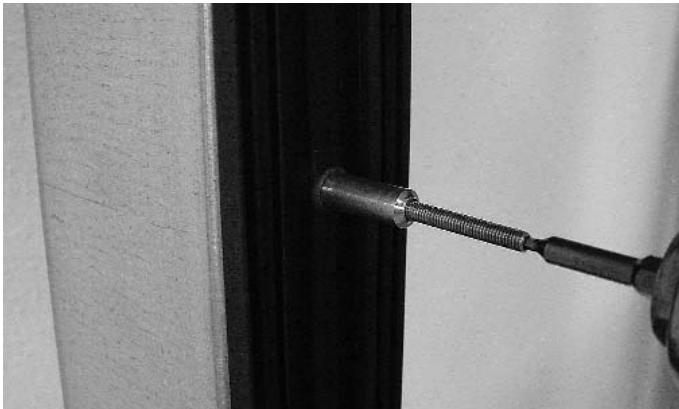
Abb. 24 Eindrehen der M4-Gewindestifte in Brandschutzanker vertikal (Pfostenbereich) Fig. 24 Ancrage de la vis sans tête M4 dans le boulon d'ancrage anti-incendie vertical (zone du montant)
