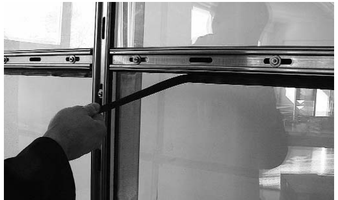
Abb. 40 Dichtungslappens abreißen Fig. 40 Arracher la languette
