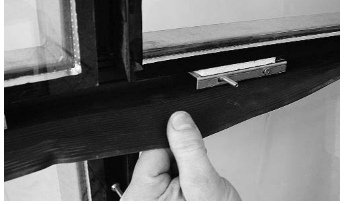
Abb. 31 Dichtungslappen der Horizontaldichtung über Füllelement legen und leicht nach unten ziehen Fig. 31 Poser la languette du joint horizontal sur l'élément de remplissage et tirer légèrement vers le bas
