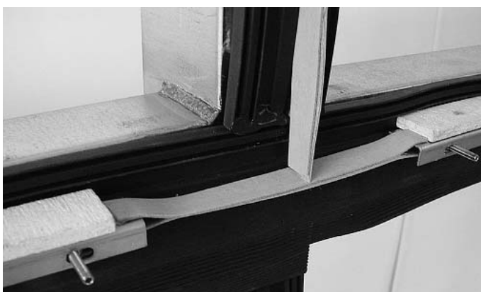
Abb. 52 Vertikales Brandschutzlaminat zwischengesetzt
