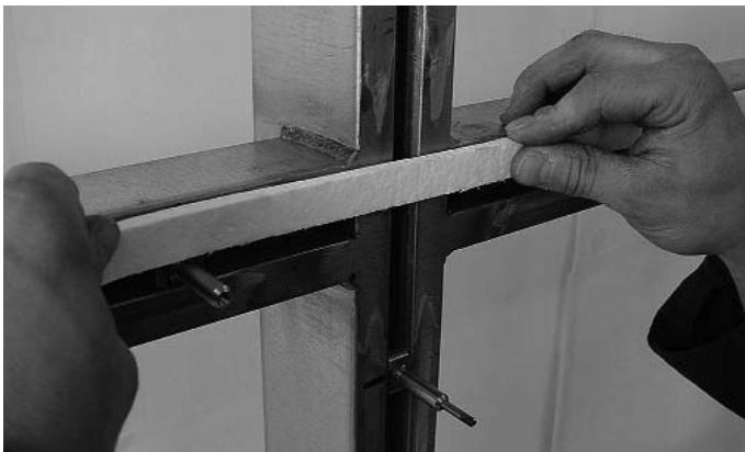
Abb. 3 Im Kreuzpunkt-Bereich werden die Keramikfaserbänder durchgehend aufgeklebt. Fig. 3 Les bandes de fibre de céramique de la zone de la traverse sont collées d'un bout à l'autre dans la zone du point de croisée.
