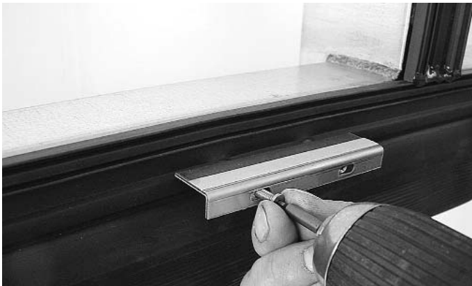
Abb. 26 Einsetzen und Befestigen der Glasauflagen mittels M4-Schraube Fig. 26 Pose et fixation des supports de verre au moyen de la vis M4
