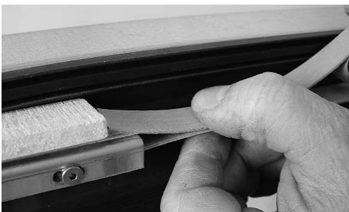
Abb. 49 Brandschutzlaminat oben zwischen Glasauflegern/ Glasklötzen ankleben.
