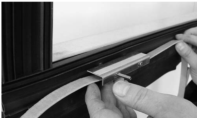
Abb. 48 Brandschutzlaminat im Riegel-Bereich unten an Glasaufleger resp. Brandschutzanker kleben.
