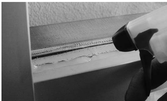
Abb. 37 Dichtstoff-Fuge mit Abglättmittel besprühen Fig. 37 Humecter le joint d'étanchéité avec de l'eau savonneuse
