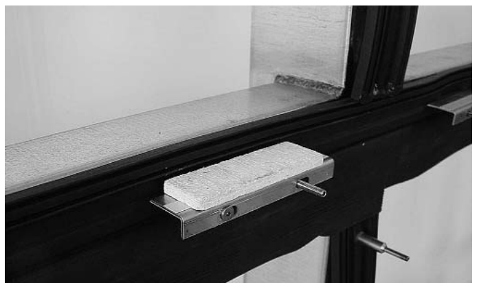
Abb. 29 Glasklotz auflegen und satt andrücken Fig. 29 Poser la cale et bien appuyer
