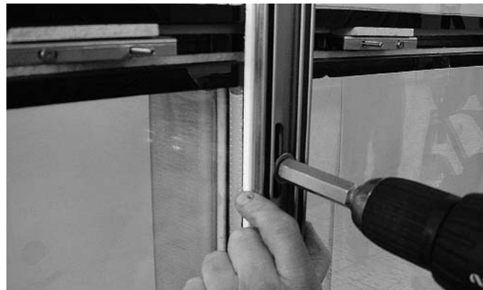
Abb. 20 Vertikale Anpressprofile anlegen und festschrauben Fig. 20 Poser les profilés de fixation verticaux et visser à fond
