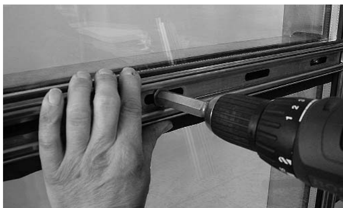
Abb. 36 Horizontales Anpressprofil festschrauben. Anziehen mit Spezialschlüssel 499.254, Drehmoment 1 Nm*. Fig. 36 Visser le profilé de fixation horizontal à fond. Serrage avec clé spéciale 499.254, couple de serrage 1 Nm*.
