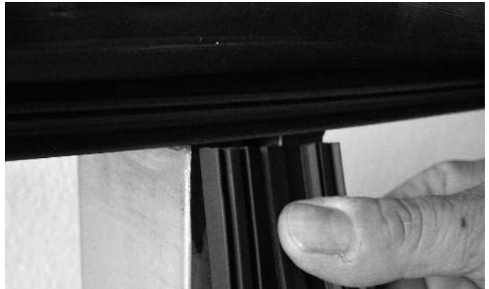
Abb. 13 Dichtung anlegen und satt andrücken
