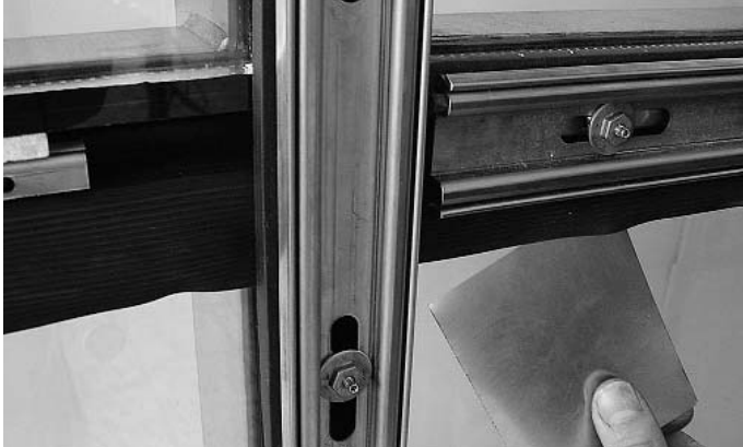
Abb. 37 Schneidunterlage (z.B. Inox-Blech 0,5 mm) unter Dichtungslappen schieben
