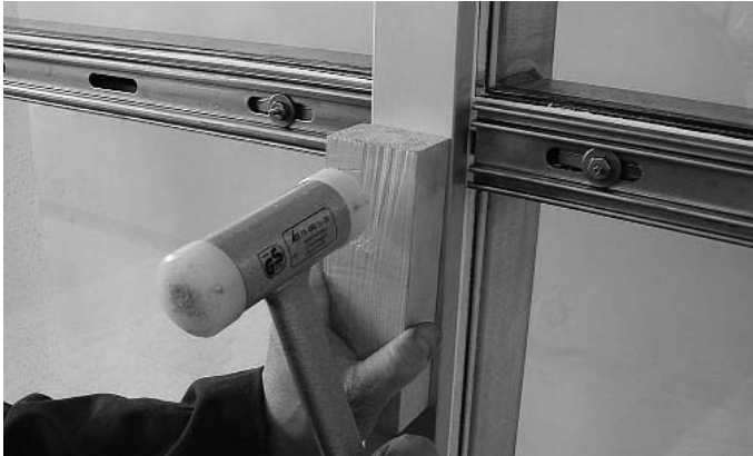
Abb. 23 Aufschlagen der vertikalen Abdeckprofile Fig. 23 Frappe des profilés de recouvrement verticaux
