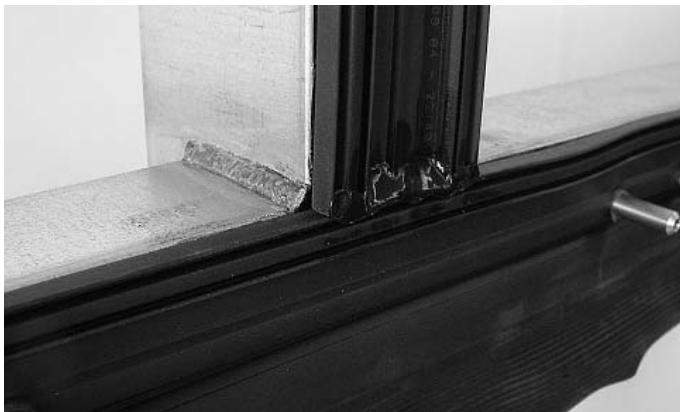
Abb. 17 Abgedichteter Dichtungsstoss im Riegelbereich oben
