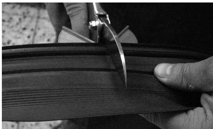
Abb. 1 Zuschnitt der Horizontaldichtung Fig. 1 Coupe du joint horizontal
