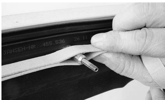
Abb. 50 Brandschutzlaminat im Bereich Brandschutzanker
