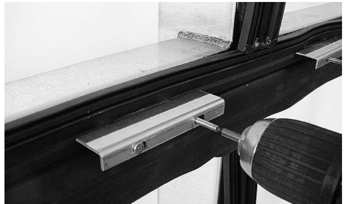
Abb. 27 Eindrehen Gewindestift bei Glasauflagen Fig. 27 Ancrage de la vis sans tête pour les supports de verre
