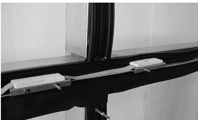
Abb. 51 Brandschutzlaminat im Kreuzpunkt-Bereich horizontal durchlaufend
