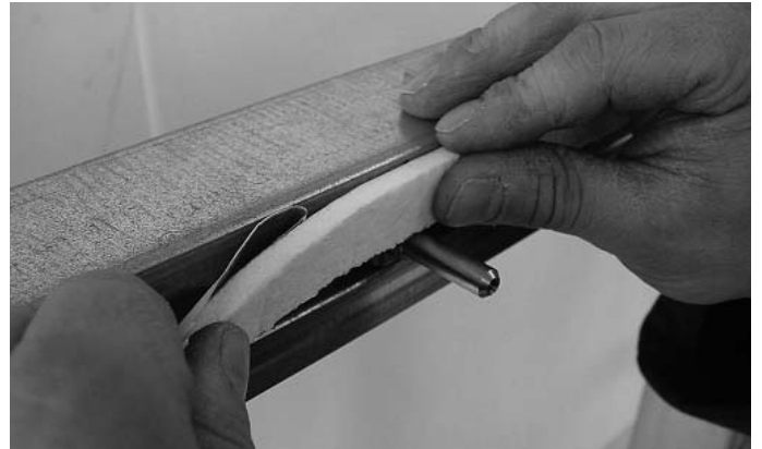
Abb. 2 Keramikfaserband auf Riegel setzen und andrücken Fig. 2 Poser la bande de fibre de céramique sur la traverse et appuyer
