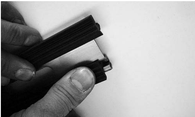
Abb. 22 Einbau-Situation der Aussendichtungen im Riegelbereich
