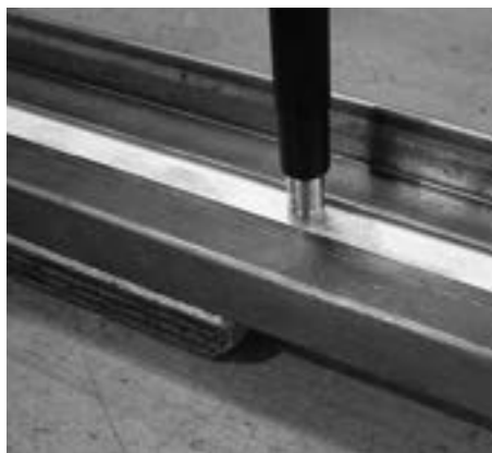
Einschlagen des Belüftungsrohres Enfoncement du tube de ventilation Driving the ventilation tube home
