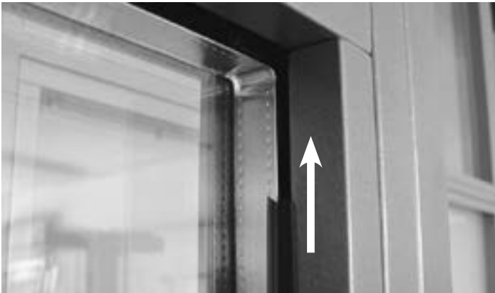
Eindrücken der Dichtung in Richtung Ecke Enfoncement du joint en direction de l'angle Pressing the gasket in the direction of the corner
