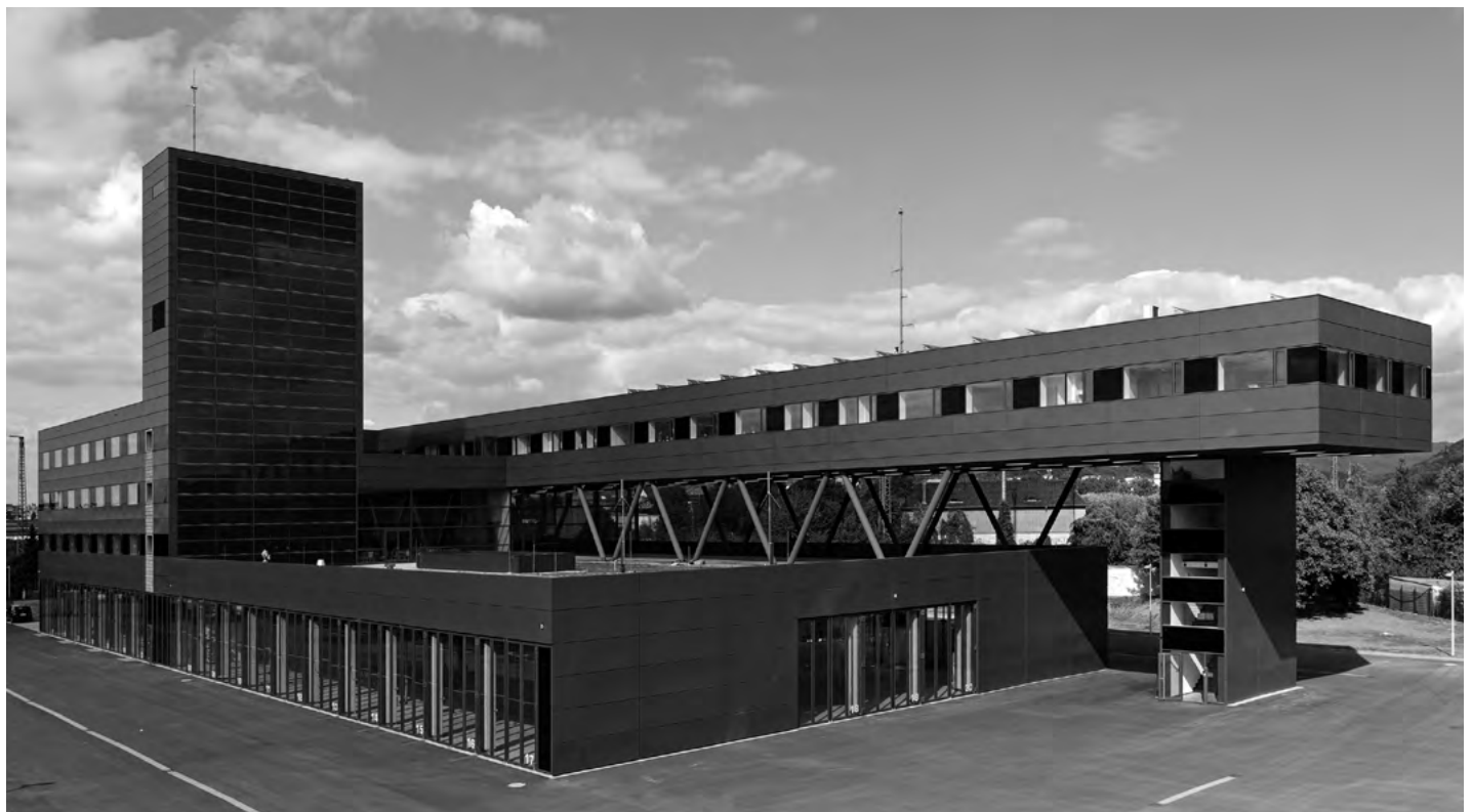
Feuerwehrwache Heidelberg, Heidelberg/D
