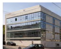
40 Geschäftshaus, Zürcherstrasse, St.Gallen/CH
