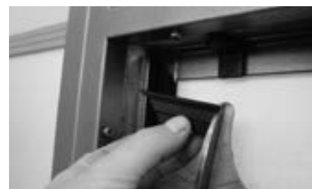
Freistellen im Bereich Belüftungswinkel Interruption dans la zone équerre d'aération Freeing in the region of the angle for glazing rebate ventilation
